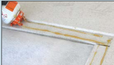
Posa massetto a secco G PLASTER FIBER
