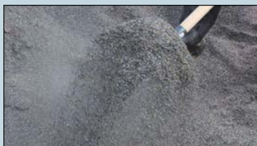
Posa sottofondo a secco G MIX GRANULAR
