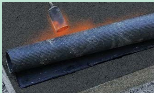
Saldatura guaina bituminosa su primer
