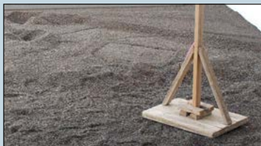
Posa massetto a secco G PLASTER FIBER
