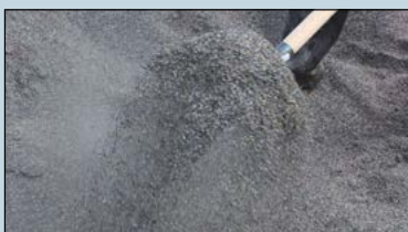
Posa sottofondo a secco G MIX GRANULAR
