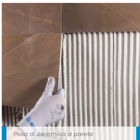
Posa di ceramica effetto legno su supporto impermeabilizzato con Mapelastic
