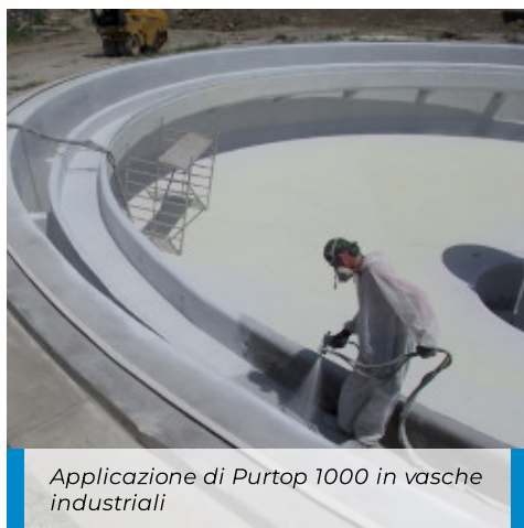
Vasche impermeabilizzate con Purtop 1000
