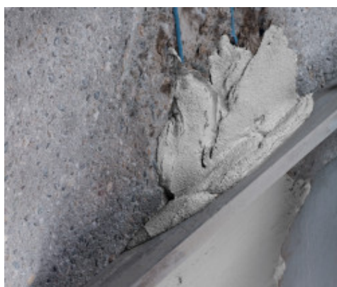
Staggiatura di Planitop Rasa & Ripara
