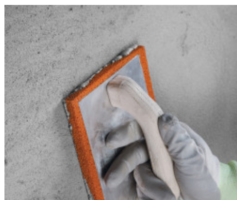
Frattazzatura di Planitop Rasa & Ripara
