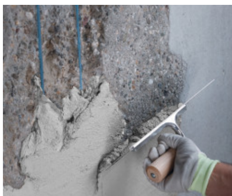
Applicazione a spatola di Planitop Rasa & Ripara
