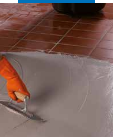
Stesura del secondo strato di Monolastic su Mapebet 150
