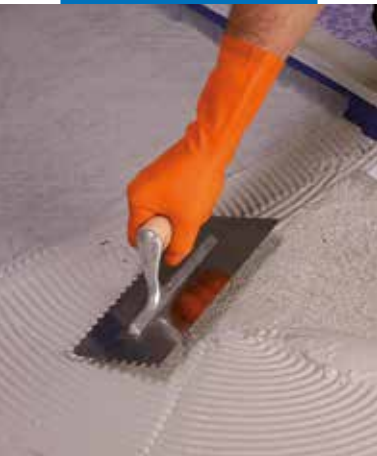
Stesura del primo strato di Monolastic armato con Mapetex Sel su nuovo massetto
