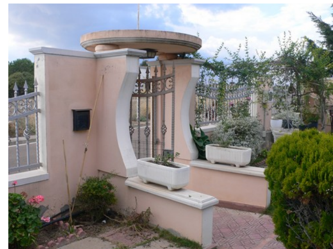
PRIMA DEL RESTAURO
