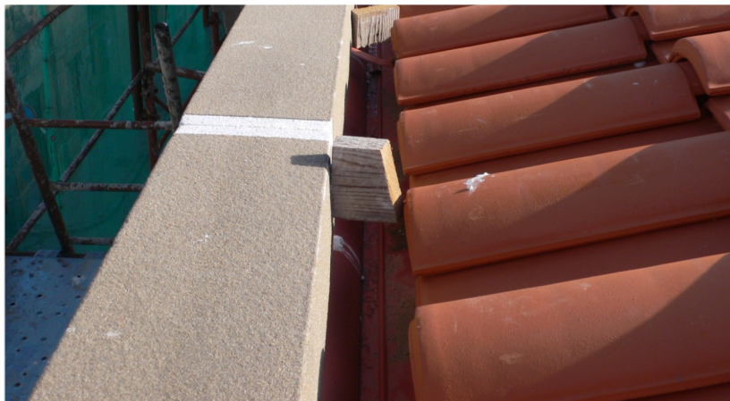
Fase di montaggio dei cornicioni copri gronda
