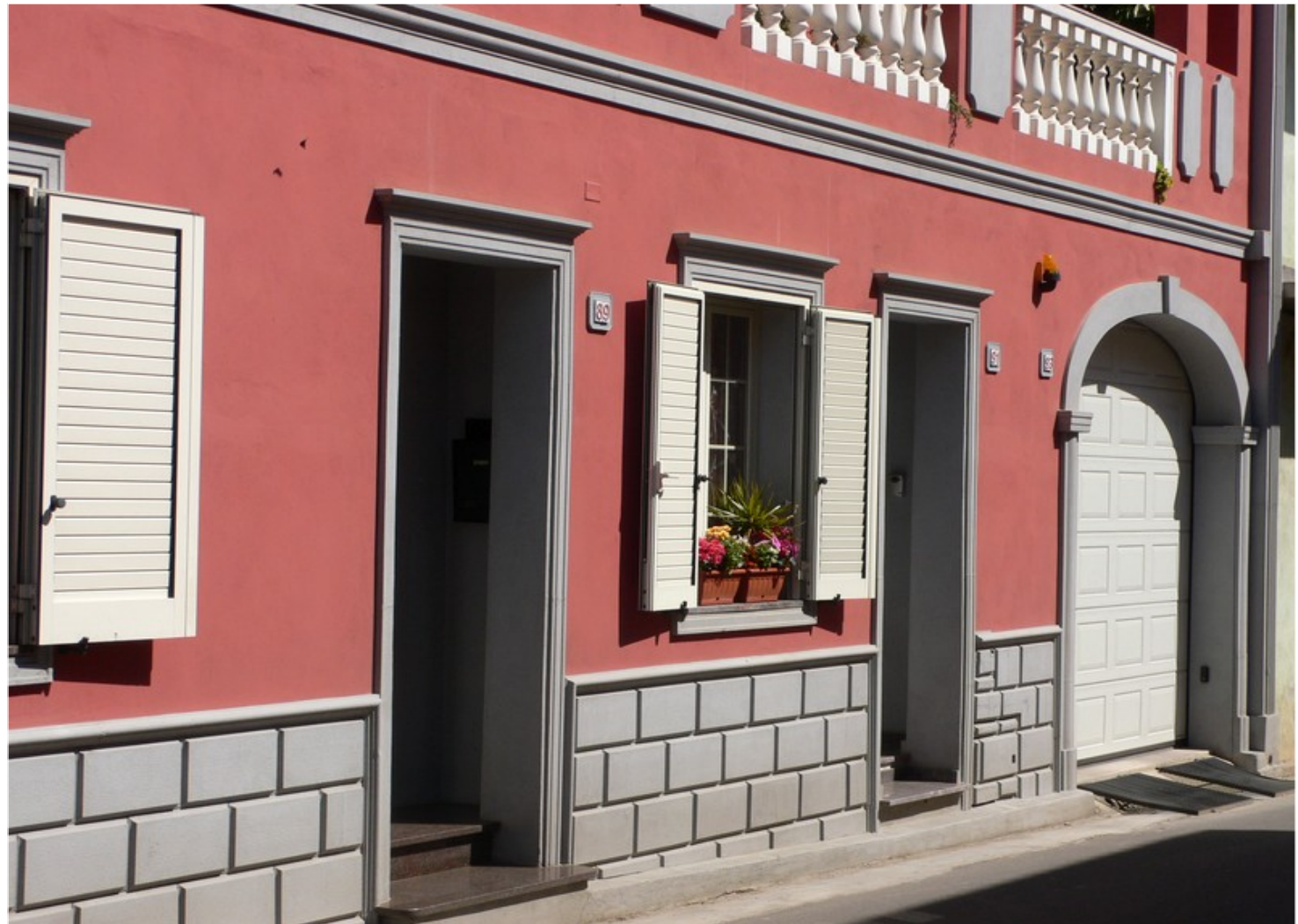
ZOCCOLATURA REALIZZATA CON BUGNE ART.CL30-40 + CORNICE ART.MB805
