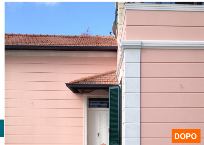
RIVESTIMENTO CON FASCE CAPPOTTO ART. FSL33
