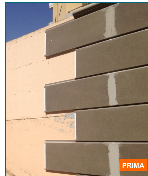
FASE DI MONTAGGIO CON FASCE A CAPPOTTO
