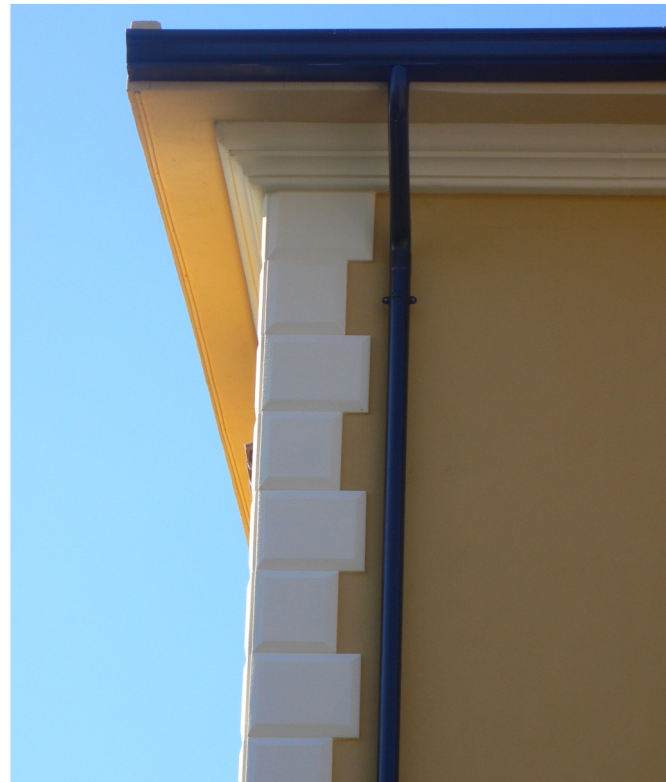
CORNICIONE ART. CN235 + BUGNE ART. MS30-30 E MS30-40
