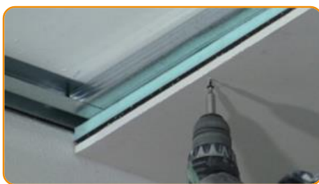
Fissare il pannello Rewall ai profili metallici con viti da 55 mm ogni 15 cm
