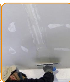
Applicare il nastro in rete nelle giunzioni delle lastre. Stuccare le giunzioni
