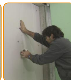
Stuccare le giunzioni CONTROSOFFITTO IN ADERENZA
