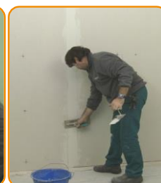
Stuccare le giunzioni CONTROSOFFITTO IN ADERENZA
