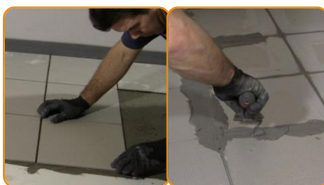
Posare la pavimentazione in ceramica o legno
