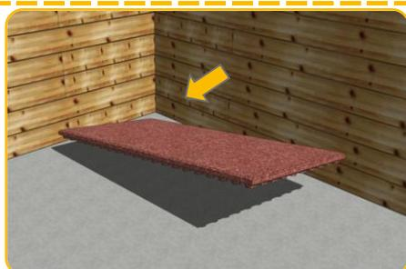
Installare la prima fila di piastre fino al bordo dall'altro lato controllando il corretto allineamento e la perpendicolarità
