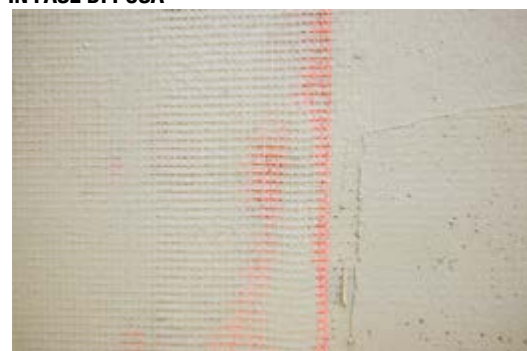
IN FASE DI POSA
