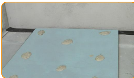
Stendere la colla a tasti sul pannello a terra
