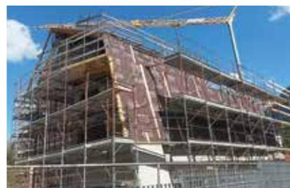
**USB Elefant** è una membrana impermeabile ad alta traspirazione a tre strati; gli strati superiore ed inferiore sono rappresentati da tessuti non tessuti in polipropilene di alta grammatura che vanno a proteggere il film centrale in polipropilene UV 10 PP Plus. I tre strati vengono accoppiati e saldati tra loro tramite termosaldatura ad espansione molecolare.
