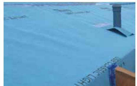
**USB Classic Light** è una membrana impermeabile ad alta traspirazione a tre strati; gli strati superiore ed inferiore sono rappresentati da tessuti non tessuti in polipropilene che vanno a proteggere il film centrale in polipropilene UV 10 PP Plus. I tre strati vengono accoppiati e saldati tra loro tramite termosaldatura ad espansione molecolare.
